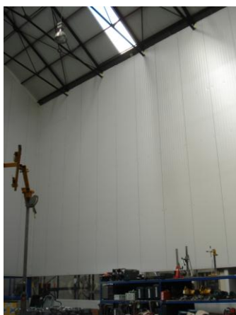
Travaux de cloisonnement
